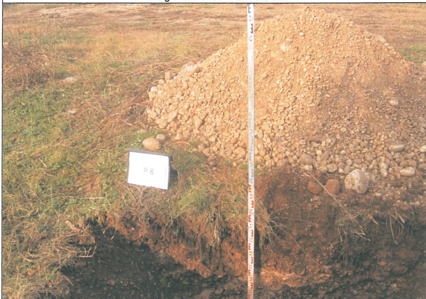
Vista d'insieme della sezione stratigrafica relativa alla trincea esplorativa n.8 e litologia rinvenuta durante lo scavo
