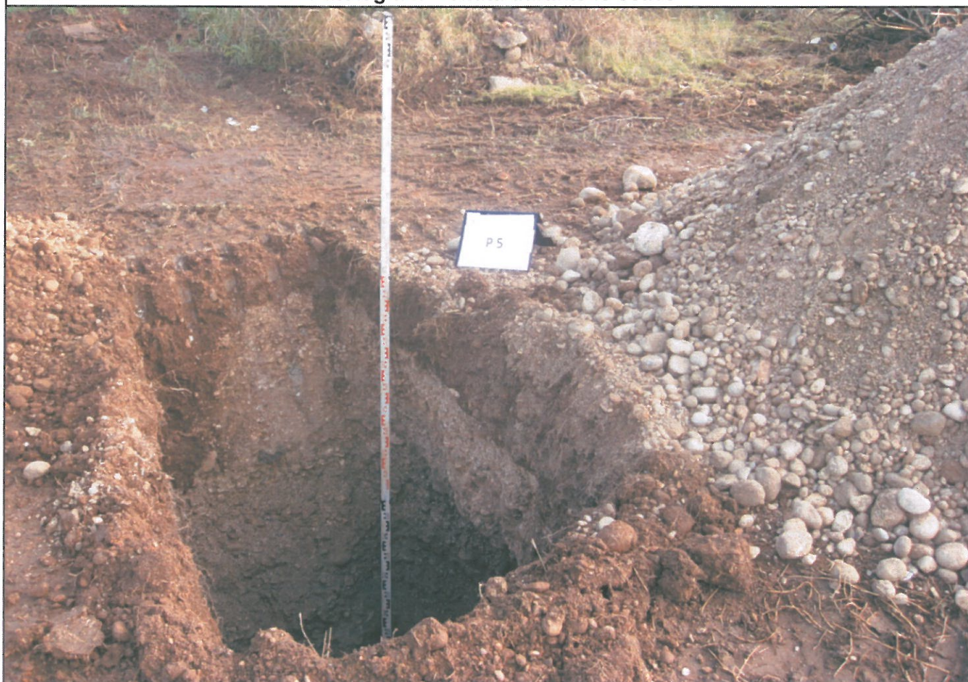
Vista d'insieme della sezione stratigrafica relativa alla trincea esplorativa n.5 e litologia rinvenuta durante lo scavo
