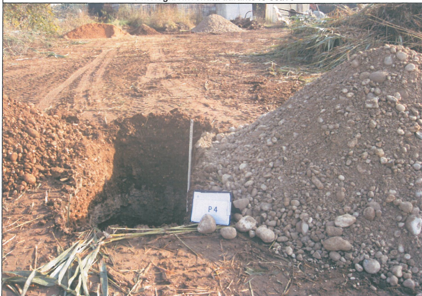
Vista d'insieme della sezione stratigrafica relativa alla trincea esplorativa n.4 e litologia rinvenuta durante lo scavo
