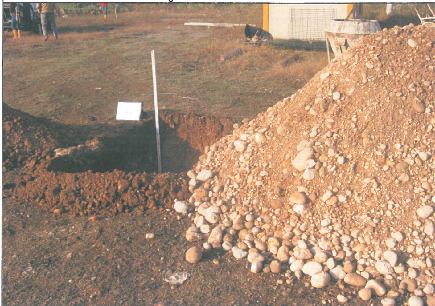
Vista d'insieme della sezione stratigrafica relativa alla trincea esplorativa n.1 e litologia rinvenuta durante lo scavo
