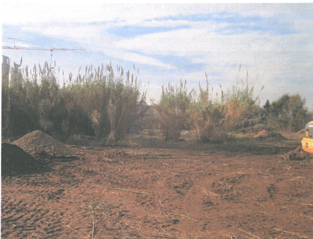
Area di indagine vista da ovest
